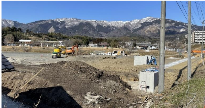
▲ 造成工事が進むこども園建設用地
