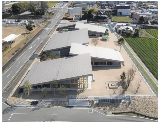
こども園西側より。CLT材の大きな屋根が山々のように連なって見えます。
